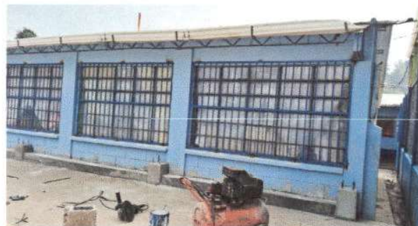
Protección de vidrios de ventanas de las aulas para el mejor cuidado de los mismos
