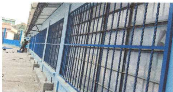
Terminación de colocación de Balcines de ventanas de las aulas de la CPB anexa a EORM Aldea Sícabe Bella Vista
