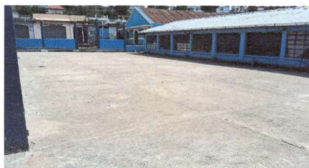
Vista Perspectiva del proyecto terminado de colocación losa de patio
